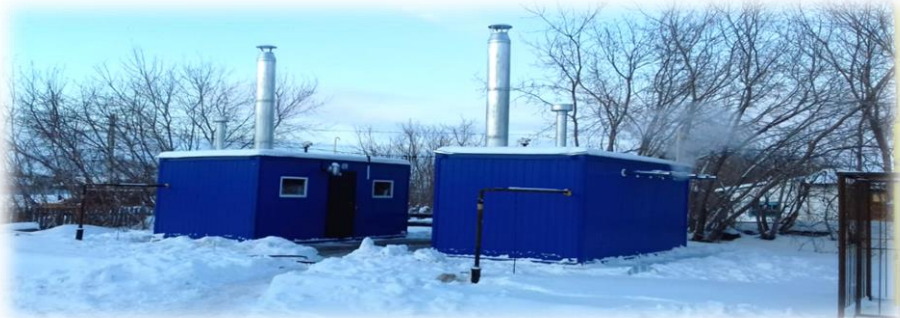
Строительство модульных газовых котельных
