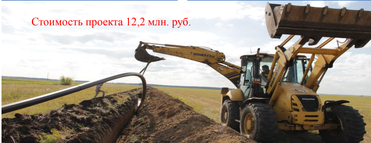
Строительство инженерных сетей
