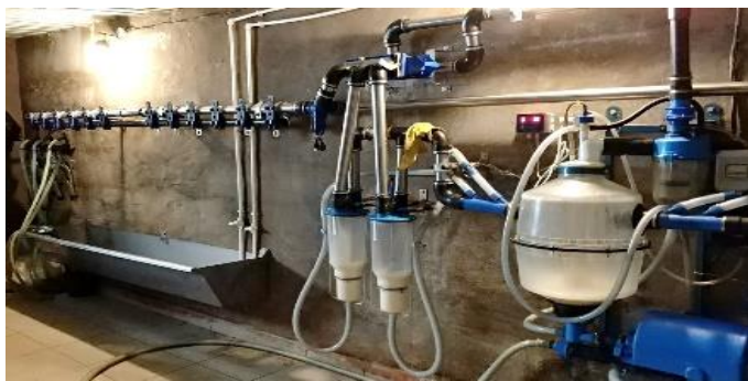
СПК «Украинский» «Модернизация и реконструкция доильного оборудования на 1100 голов» Инвестиции более 10 млн. руб.
