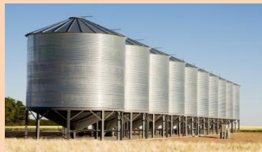
Наличие 2 элеваторов с железнодорожным тупиком
