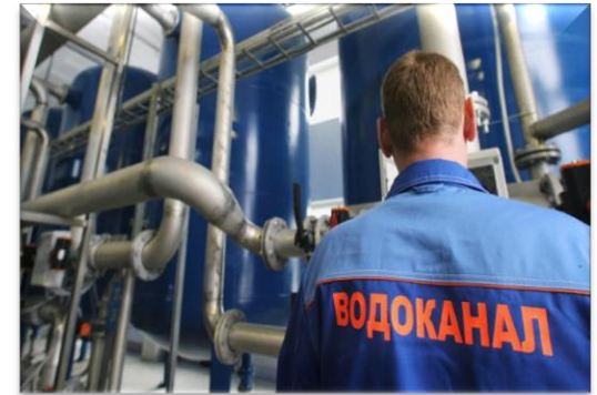
МУП Кормиловский «Водоканал» Обеспечивает район водоснабжением и водоотведением
