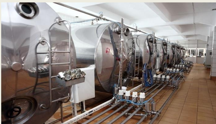
Срок реализации - 2019 - 2020 гг. Реконструкция консервного цеха, здания гаража, строительство склада
