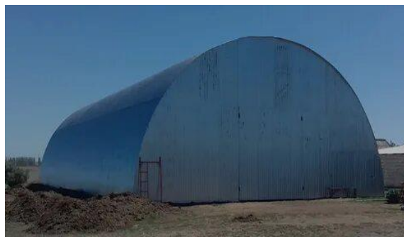
Строительство зерносклада в с. Крестики ООО «Сибирская мука»
