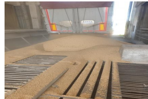
Строительство поточной зерноочистительной линии ИП Глава КФХ Тоом А.Р.
