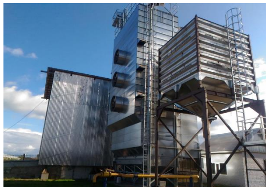
Строительство зерносушилки ООО «Агрокомплекс Маяк»
