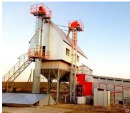
Строительство зерносушилки КФХ Мерко А.В.
