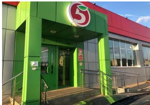
Строительство помещения для размещения торговых объектов ИП Якушева А.С.
