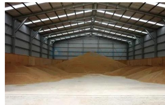
Строительство зерносклада КФХ Дроздаков А.А.
