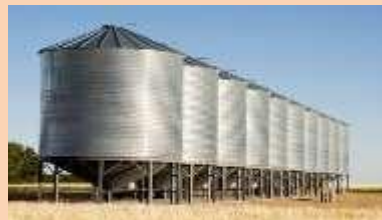
Наличие 2 элеваторов с железнодорожным тупиком
