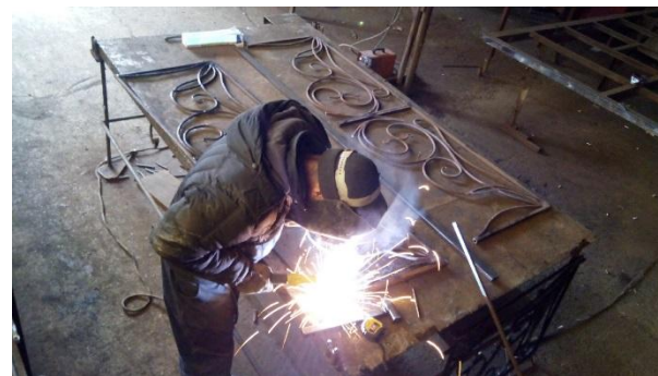
ООО «Металлресурсы» Занимается изготовлением металлических изделий и металлоконструкций
