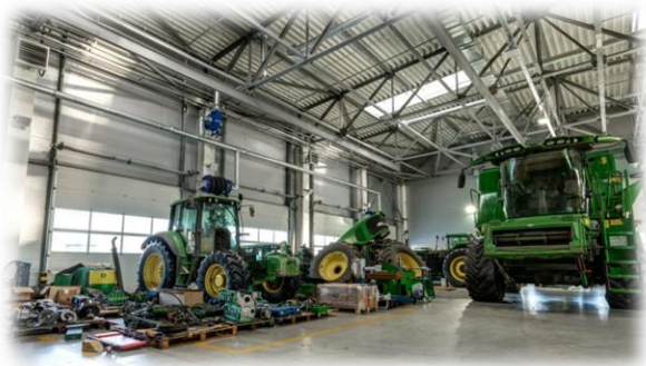
Строительство МТМ для ремонта и обслуживания автотранспорта и сельхозтехники хозяйства (с. Нижний Иртыш)
