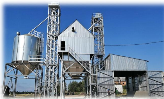
Строительство зерноочистительного комплекс для эффективной сортировки и очистки семян (с. Новотроицкое)
