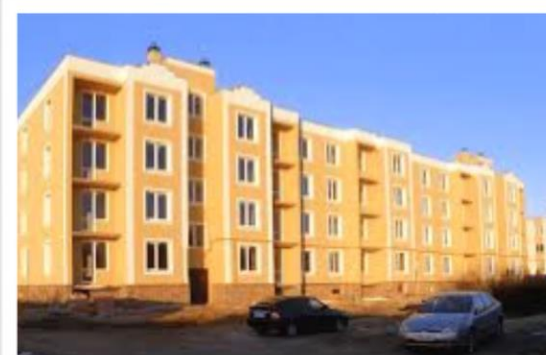
Строительство многоквартирных жилых домов в г. Таре на ул. Радищева, 14а
