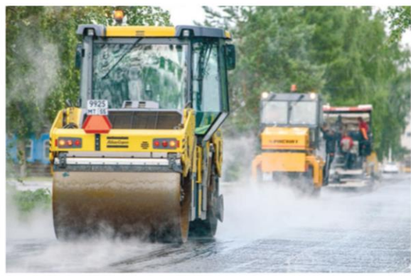
АО «Дорожное ремонтно- строительное управление №5» (ремонт автомобильных дорог)
